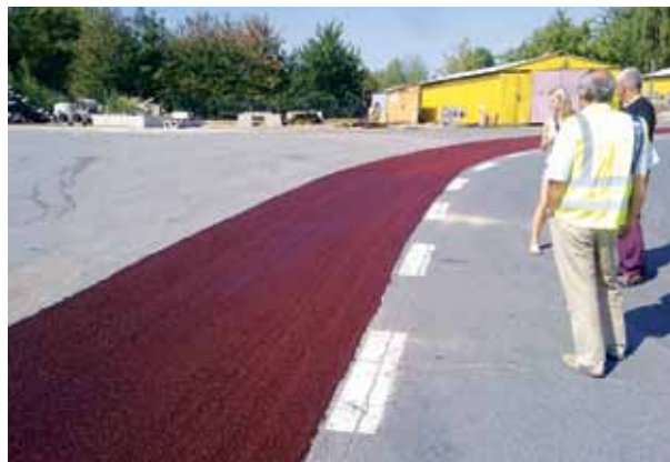
Barvené mikrokoberce na zkušební úseku.
