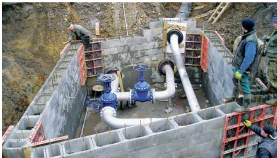
V rámci projektu Energetické úspory ve společnosti DEZA, a. s. prošly rekonstrukcí parní rozvody do systému Centrálního zásobování teplem ve Václavkově ulici.
